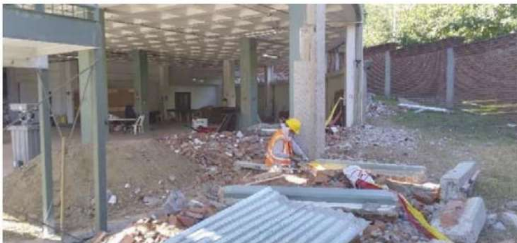
ESCARAIFICADO EN COLUMNAS
